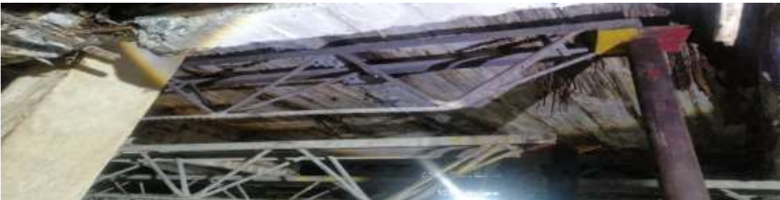
Estado de apoyo seguro con cercha y parales
