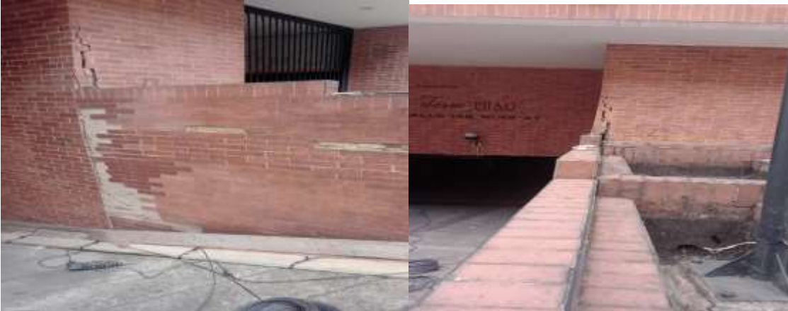
Pared entrada parqueadero sótano
