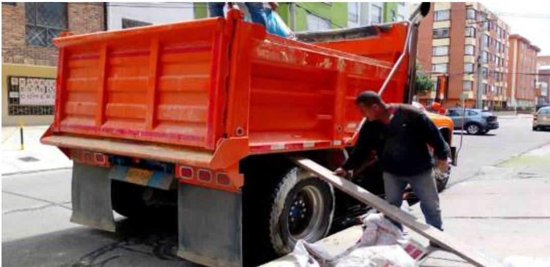
Retiro de escombros
