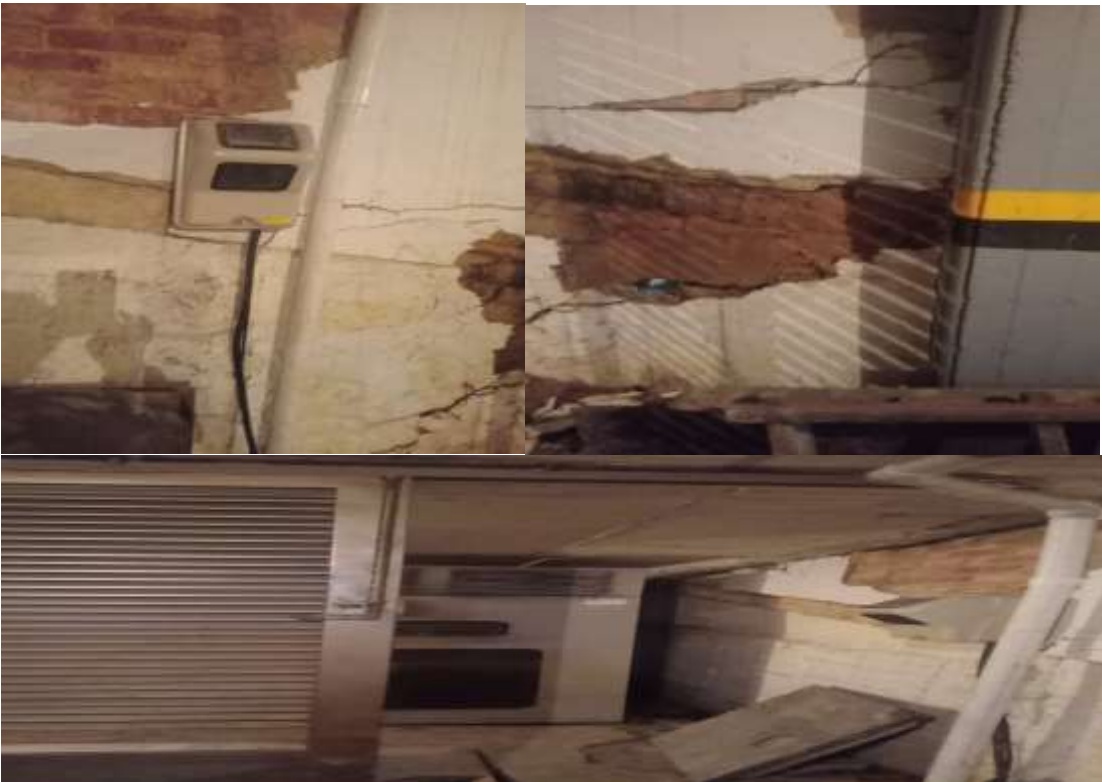
Subestación eléctrica daños estructurales
