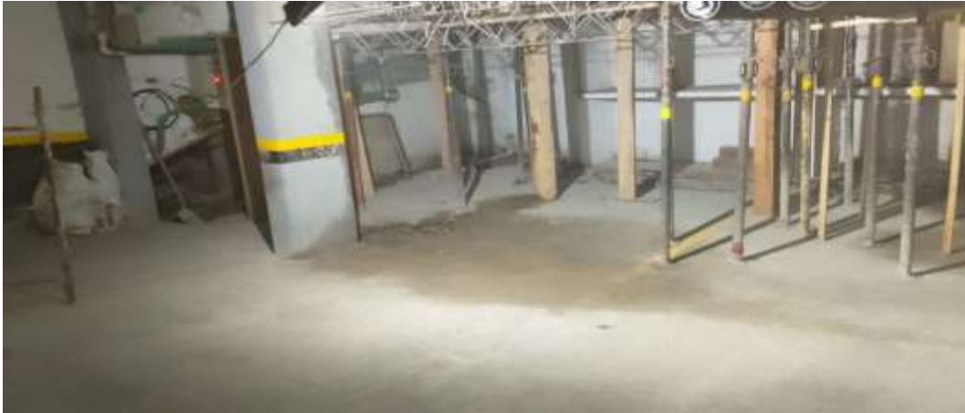
Reforzamiento de los parales
